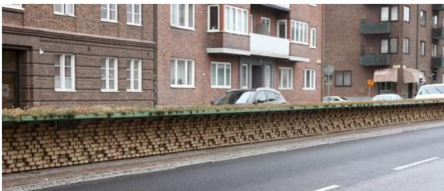
Figur 18. Bullerskyddsskärm 1,5 m Helsingborgstad. Källa: Ljudmätning rapport projnr 78250402, Efterklang.
